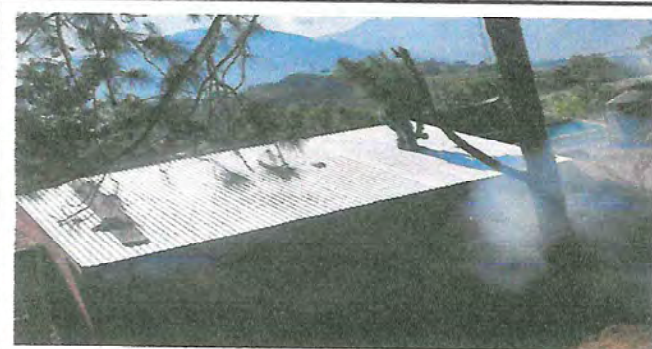
Foto 3: Cambio de techo de sanitarios
