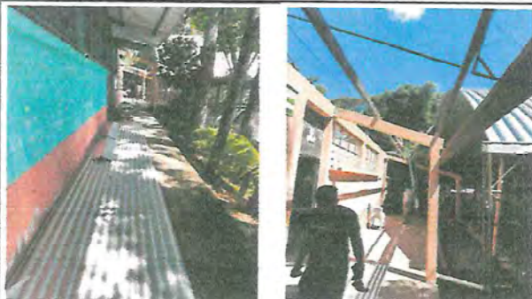
Foto 1: Recepción de material, y levantado de techo en mal estado.
