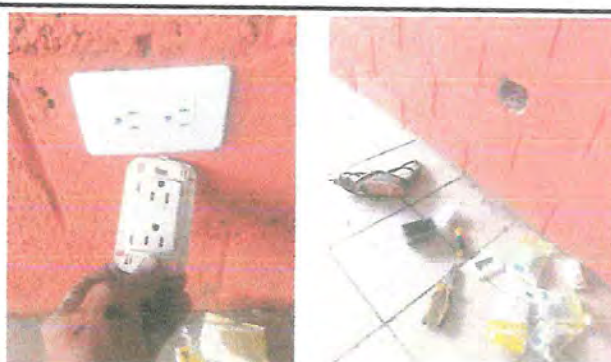
Foto 4: Reparación de tomacorrientes y cableado eléctrico.
