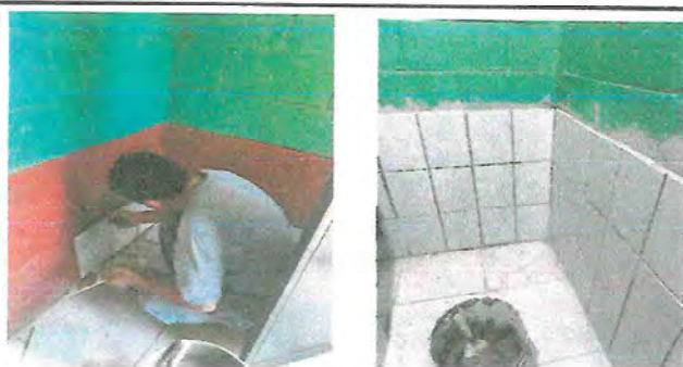
Foto 5: Puesta de azulejos.
