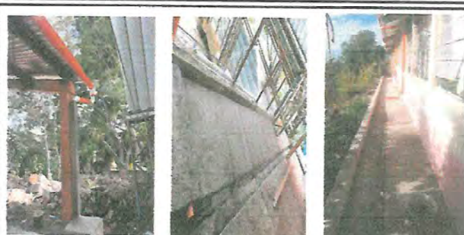
Foto 2: Proceso de reparación de cunetas y bajadas de agua modulo "C" y modulo "A".
