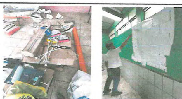
Foto 6: Reparación de sanitarios y pintura de sanitarios.
